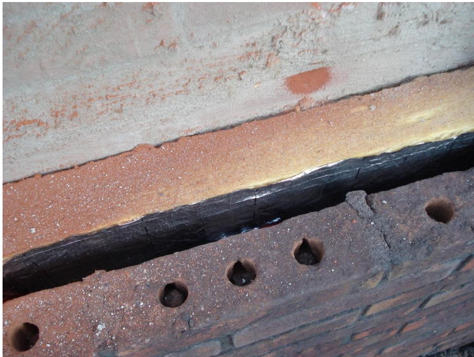
foto 1. Metselwerk uitgevoerd met een smalle baksteen
